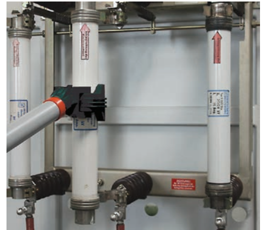
Sulakkeiden vaihto 20° käännetyllä tartuntakynnellä.
