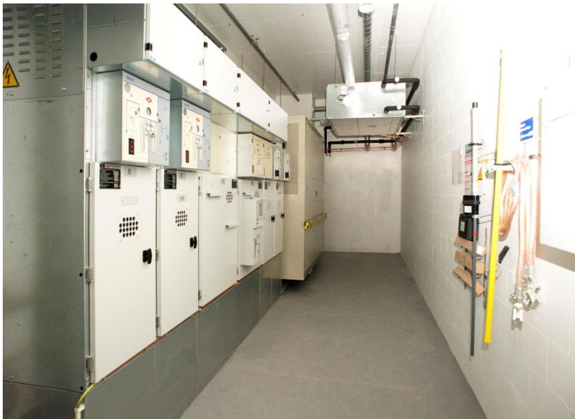
20kV muuntamolaitteet sekä ylijännite- ja salamasuojaus kiinteistöihin. Dehnin työturva valmiina varustepaketteina.
